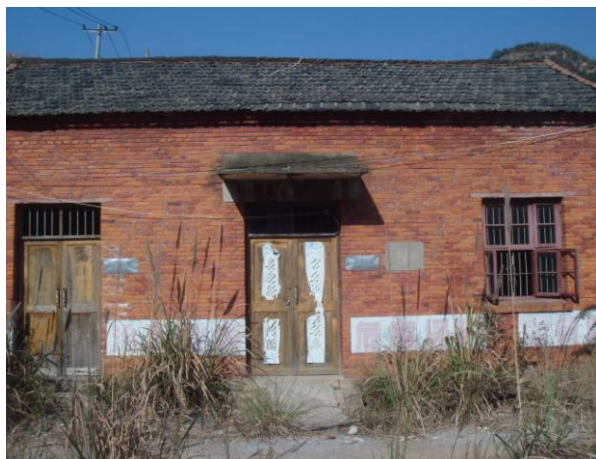
空压机房和发电机房
