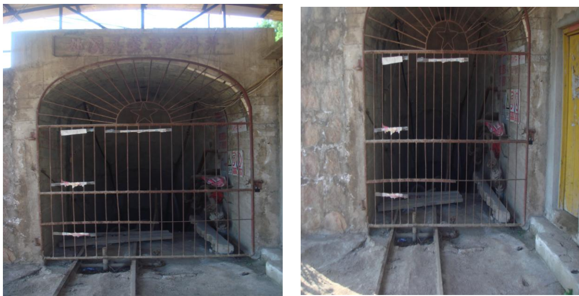
图 2-5 103 斜井采区现状
