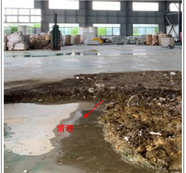
2#车间地面清理
